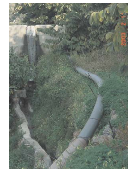
Tramo actual saneamiento de finca privada
