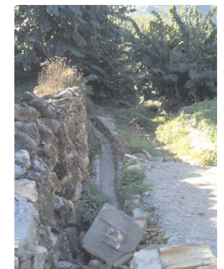
Tramo de saneamiento acequia abierta
