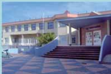
Piscina cubierta - ALMUÑÉCAR
